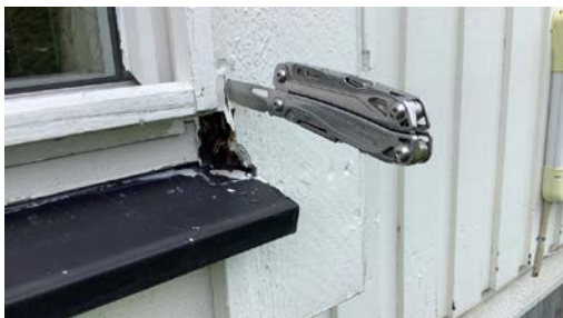
Omremming er ført helt ned til vannbrett, og dette har ført til spredte råteskader.
