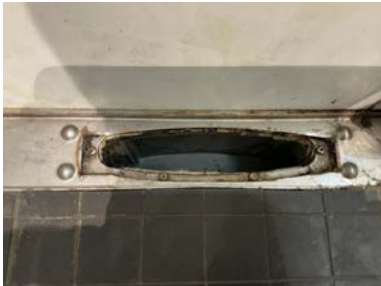
Slukrenne i dusjhjørne.
