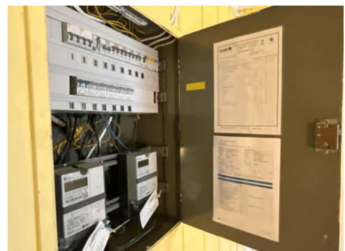
Foto av felles sikringskap i gang
