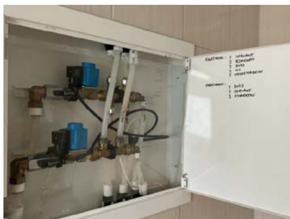
Foto av koblingskap for rør-i-rør-system
