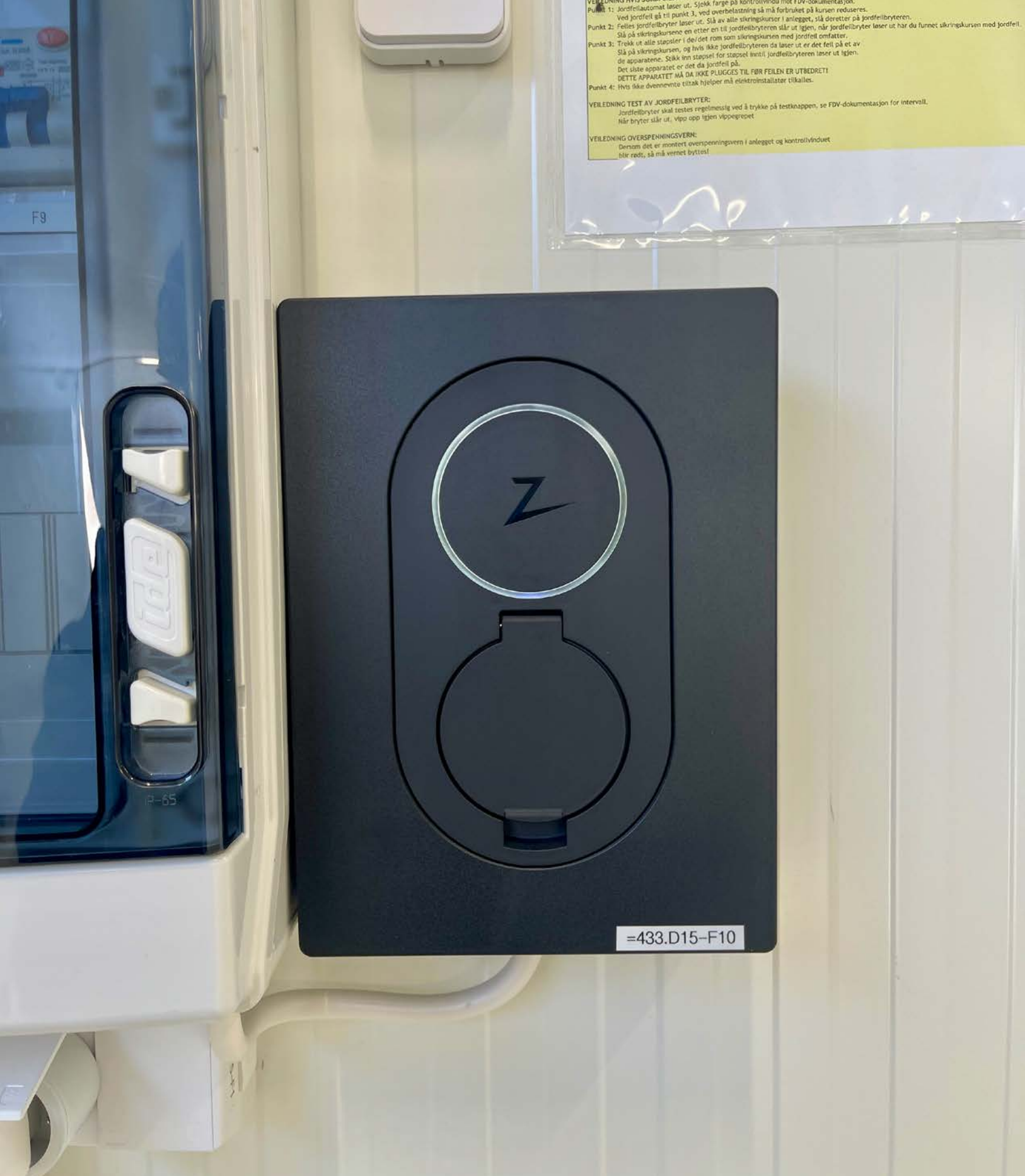
Det er montert Ziptec Go el-bil lader 11kW.
