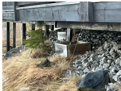
Skjevhet fundamenter.
