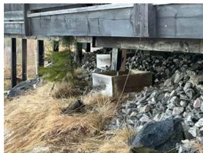
Skjevhet fundamenter.
