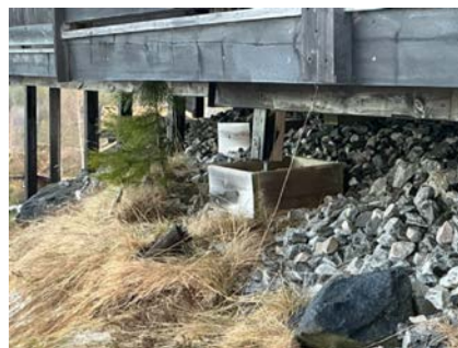
Skjevhet fundamenter.
