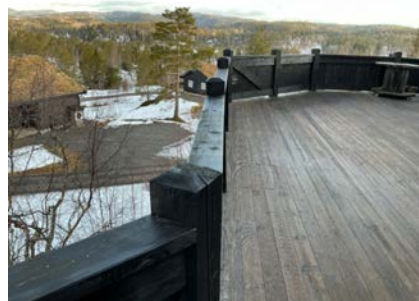
Skjevhet rekkverk.
