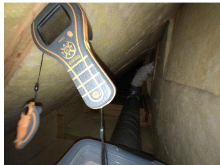
Ved enkel fuktmåling registrerte jeg tørre verdier.
