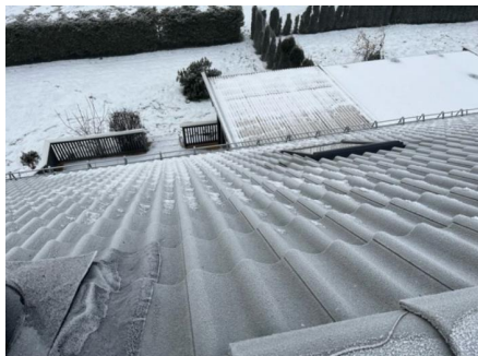
Taktekking av betongtakstein
