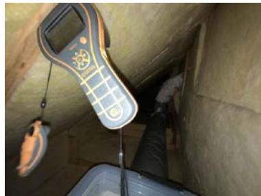
Ved enkel fuktmåling registrerte jeg tørre verdier.
