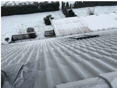
Taktekking av betongtakstein
