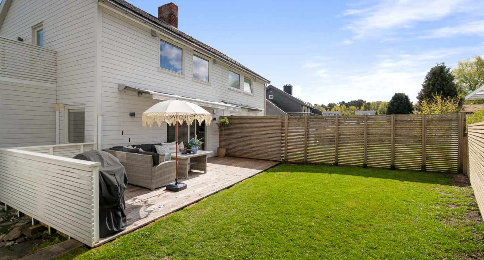
Del av tomannsbolig som er oppgradert i nyere tid med gjennomgående god standard
