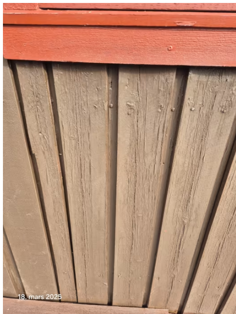
Eksempelbilde av slitt kledning.
