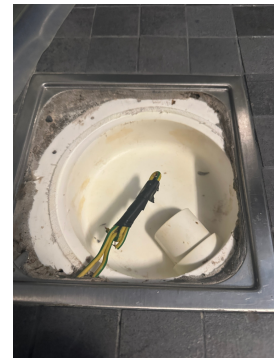
Hovedsluk i plast, plassert under servantskap.
