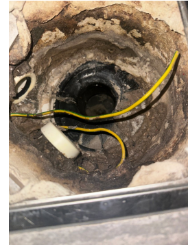
Hovedsluk i plast, plassert under servantskap.
