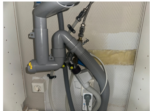
Rørapplegg i kjøkkenbenk med Waterguard
