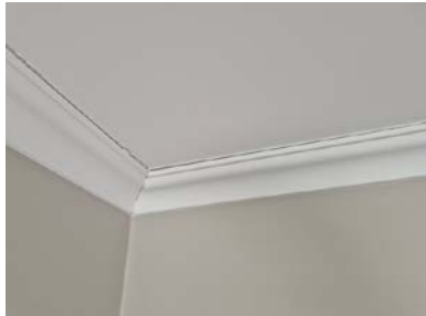
Gliper mellom taklist og takplate.
