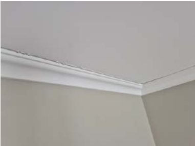
Gliper mellom taklist og takplate.
