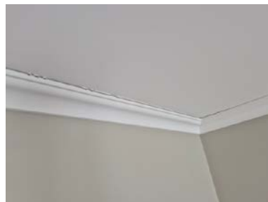
Gliper mellom taklist og takplate.
