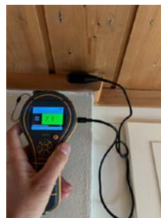
Fuktskjold ved pipestamme, ved fuktmåletaking var det ikke utslag
