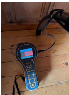
Ved fuktmåletaking av gulv mot gulvkonstruksjon var det fuktutslag
