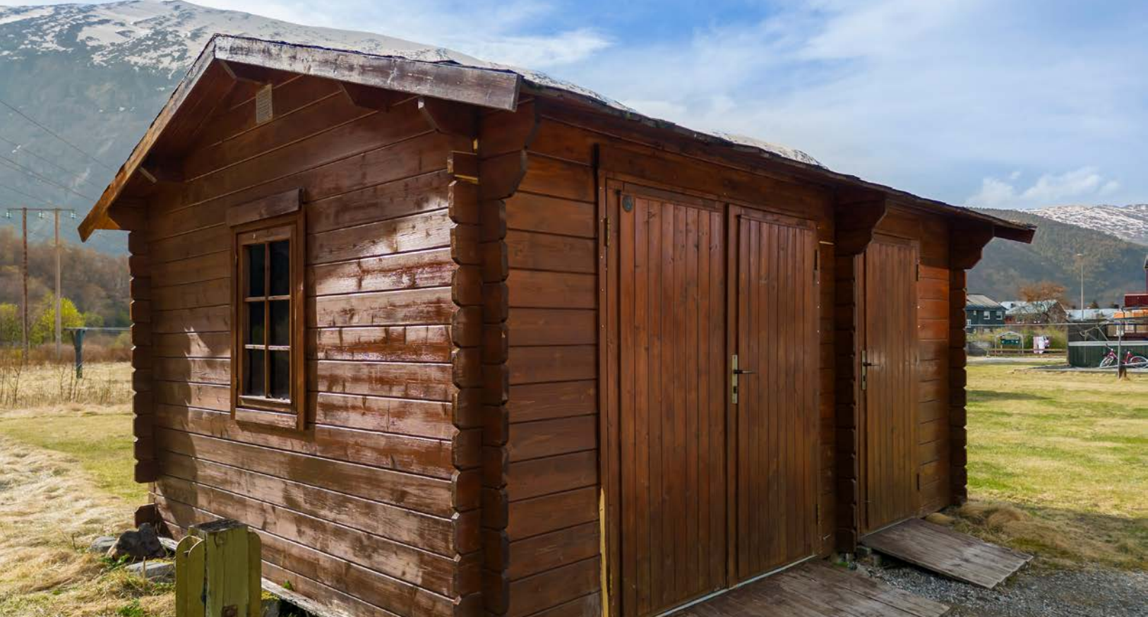
Frittstående bod gir ekstra lagringsplass.
