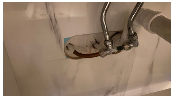
Utette rørgjennomføringer.
