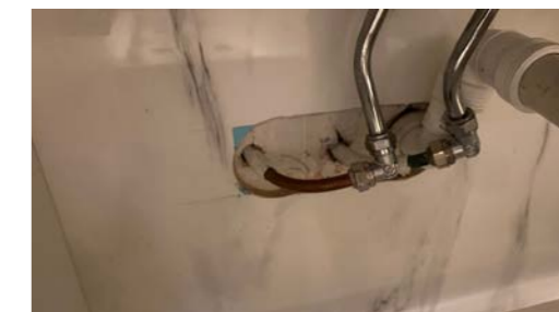
Utette rørgjennomføringer.
