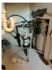
Rørøpplegg under kjøkkenbenk.
