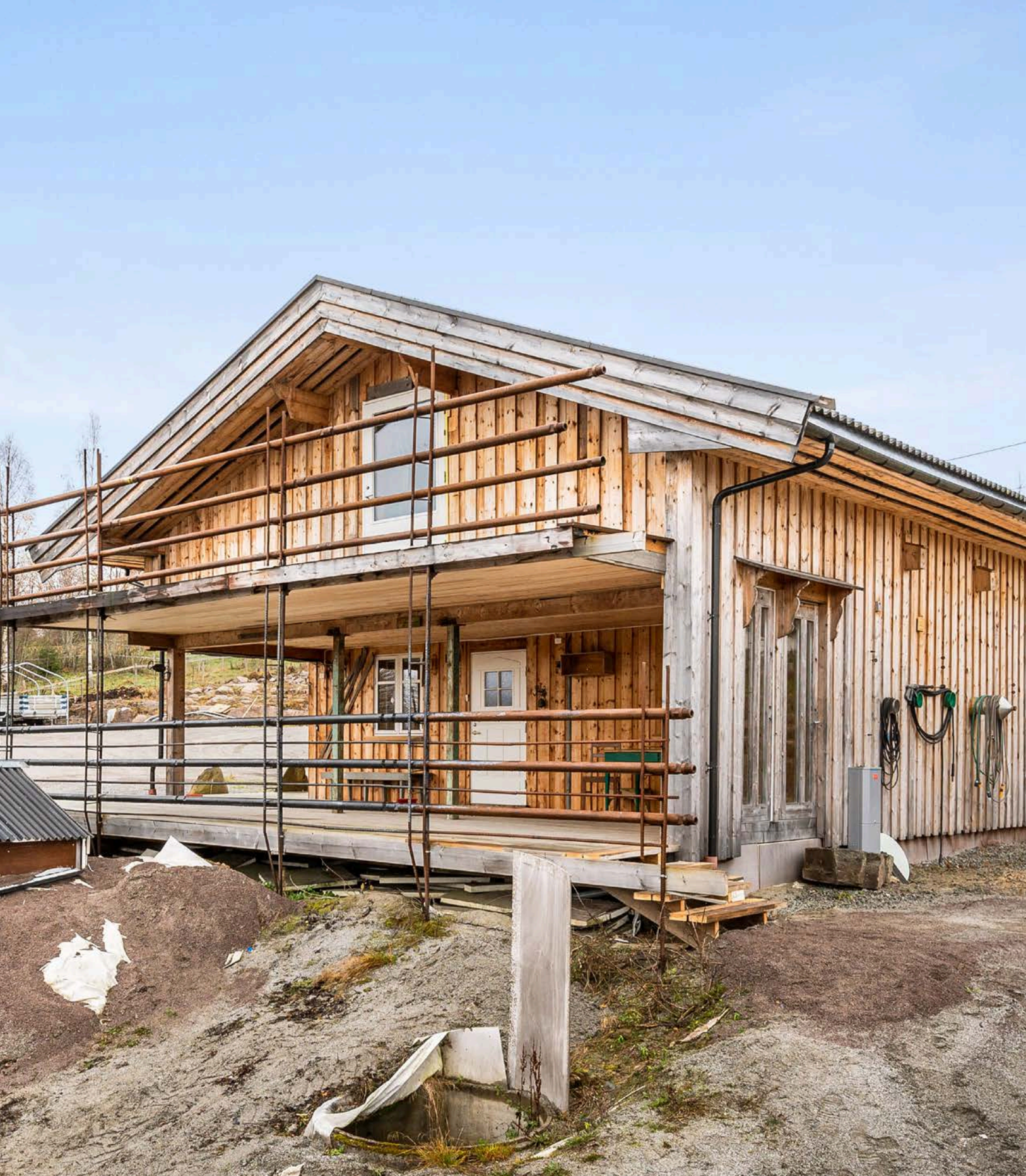
Fra boligens 2. etasje er det utgang til en balkong på ca. 15m 2 . Særegent rekkverk i stål.
