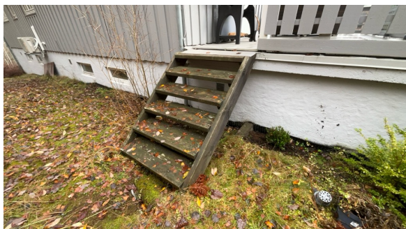
Utvendig trapp i tre.
