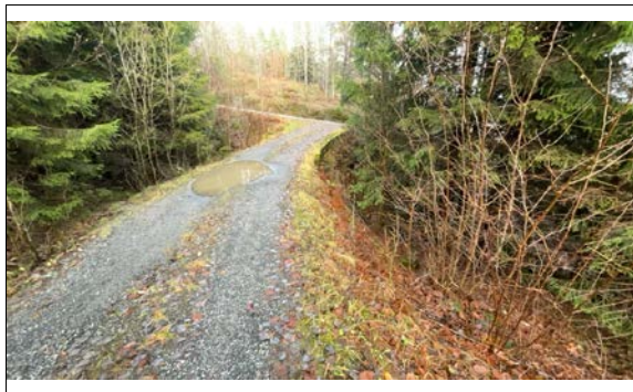
Utsnitt privat vei, del av veien mot boligen. Veien er lagt på steinfylling med rørføring for en bekk på vei inn på tunet.
