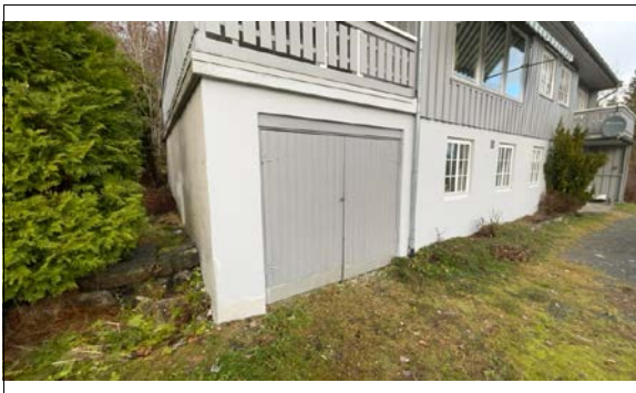
Plassbygd tredør mot bod, dette kan fungere som en garasjeport, men rommet er bare 3m dypt.
