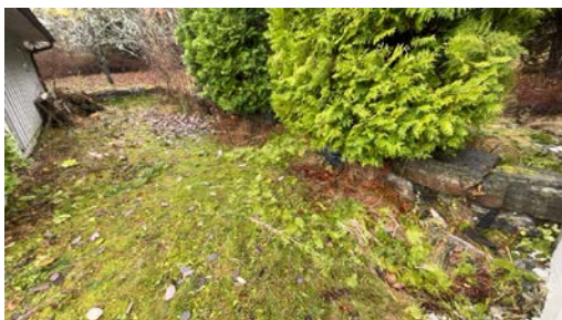
Forstøtningsmurer i naturstein.
