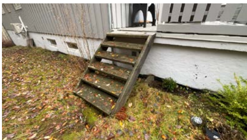
Utvendig trapp i tre.
