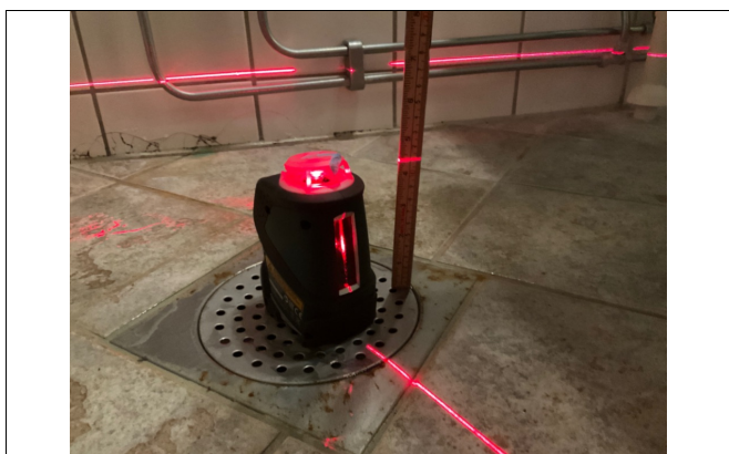
Kontroll av fall på gulv på bad.
