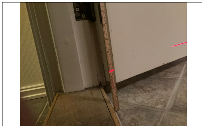
Kontroll av fall på gulv på bad.
