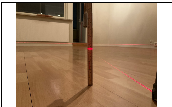
Skjevhetmåling/ nivellering av gulv.
