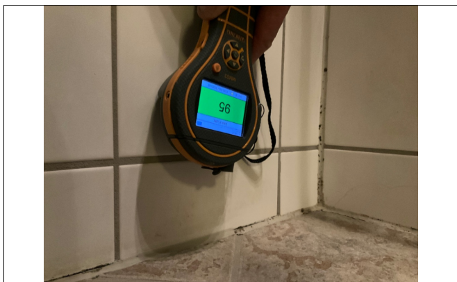
Kontroll med fuktmåler i dusjsonen.
