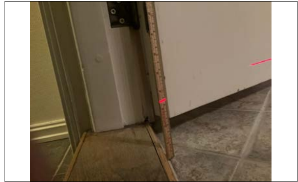
Kontroll av fall på gulv på bad.
