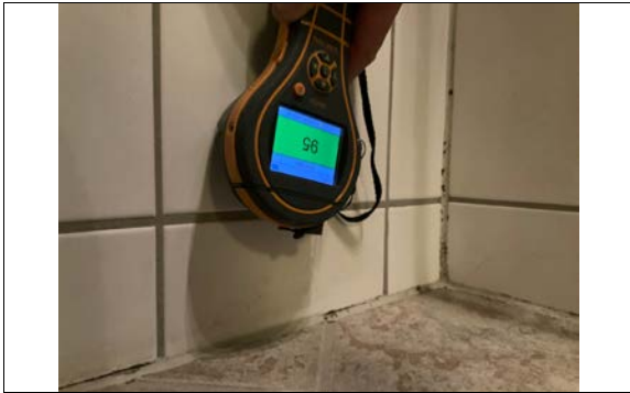
Kontroll med fuktmåler i dusjsonen.
