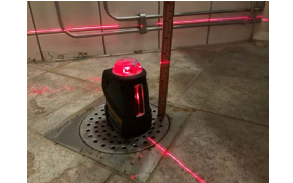
Kontroll av fall på gulv på bad.
