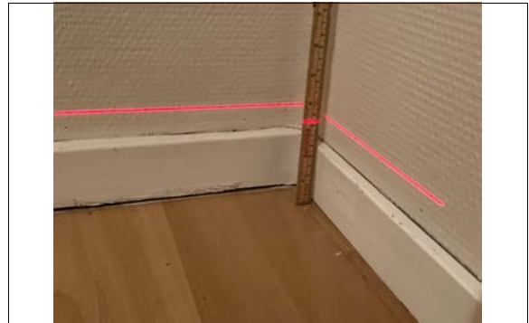
Skjevhetmåling/ nivellering av gulv.
