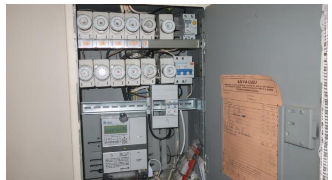
Skrusikringer. Noe oppgradert.
