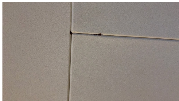
Synlig innfesting på takessplate.
