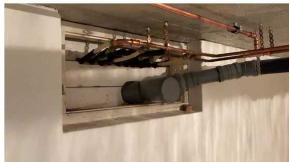
Samlestock for rør i rør
