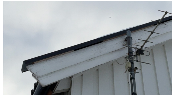
Isbordbeslag er montert på punktvis isbord.
