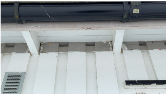
Lufting mellom tak og vegg, det er stiftet på netting på utsiden.
