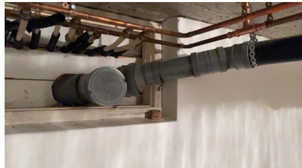
Stakepunkt i kjeller.
