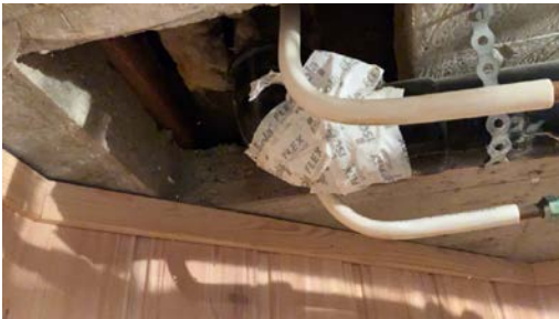
Tape på bend på avløpsrør.
