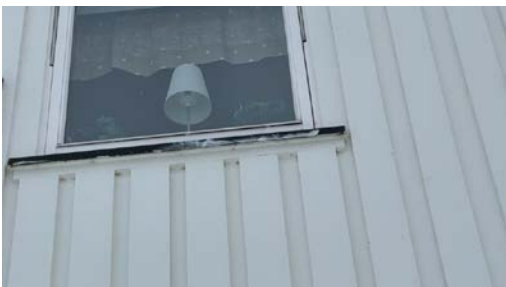
Eksempel på malingsøl på beslag.
