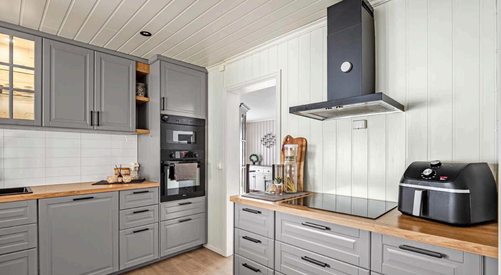
Kjøkkenventilator med kullfilter er installert over platetoppen.
