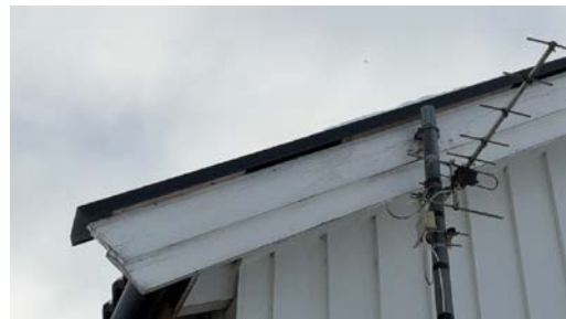
Isbordbeslag er montert på punktvis isbord.
