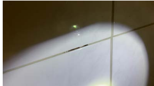
Oppsmuldring i hardfuge på vegg på ett sted.
