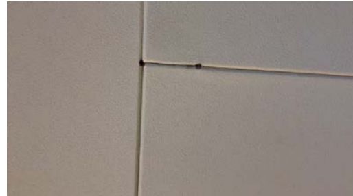
Synlig innfesting på takessplate.
