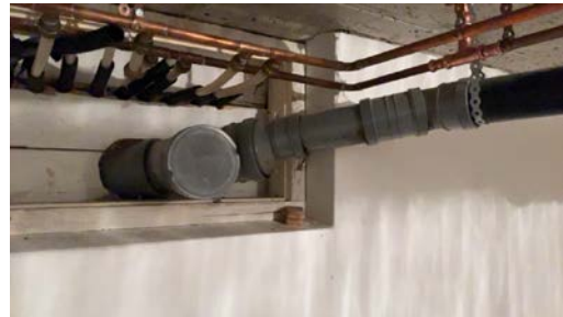
Stakepunkt i kjeller.
