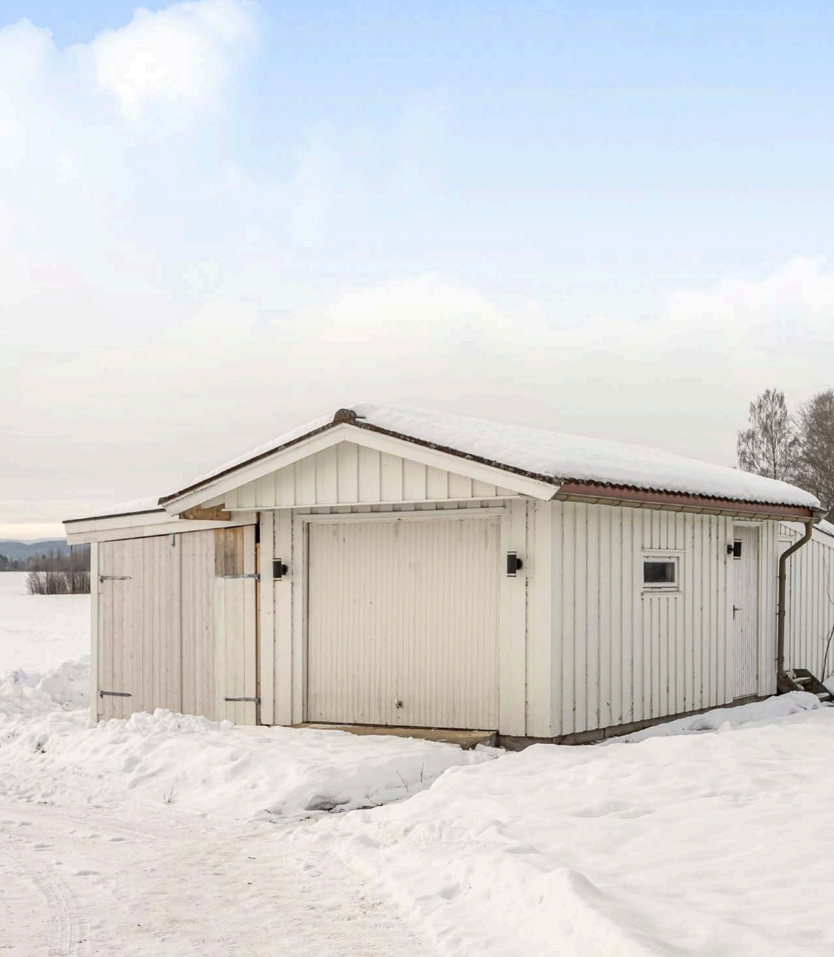
Garasjen har enkle konstruksjoner med vippeport og er fundamentert med ringmur og støpt plate.
