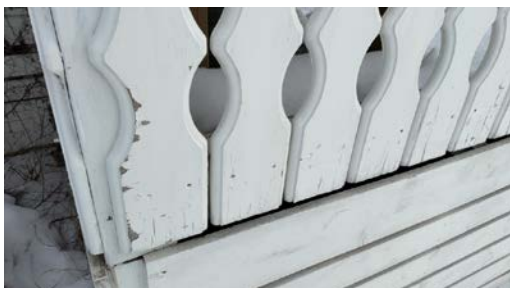
Eksempel på slitasje på hovedveranda.
