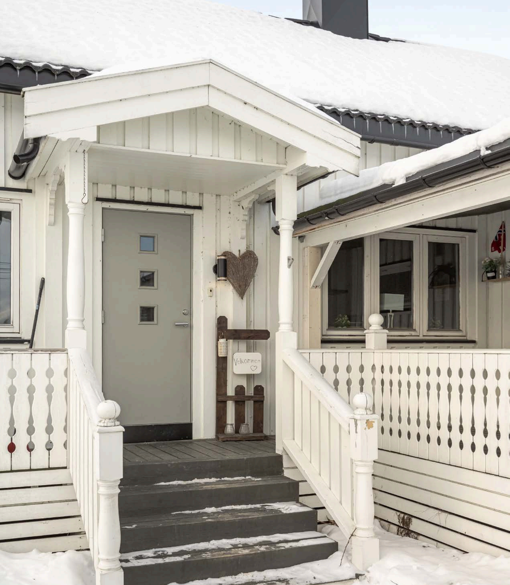
Hovedinngangen har takoverbygg og nyere inngangsdør.
