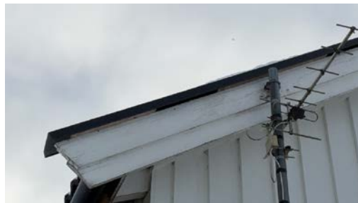
Isbordbeslag er montert på punktvis isbord.
