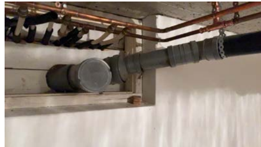
Stakepunkt i kjeller.
