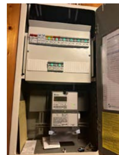
Sikringsskap med automatsikringer.
