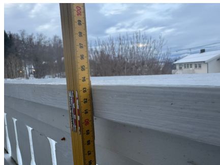
Rekkverkshøyden er 0,94 meter.
