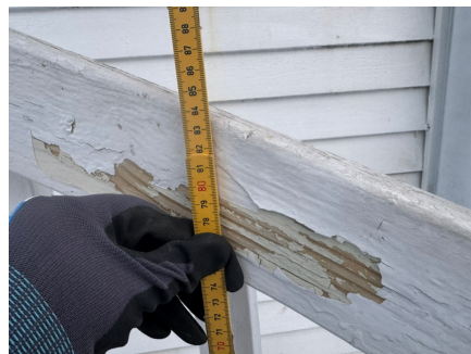
Høyde på rekkverk i trappen.
