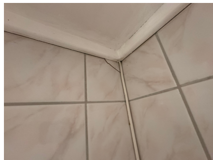
Eksempel på skadet flis.
