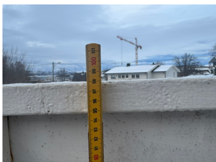
Rekkverket er målt til ca 0,98 meter.
