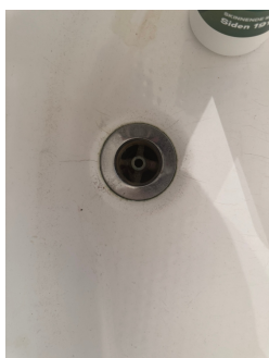
Eksempel på riss i utstyr på våtrommet.
