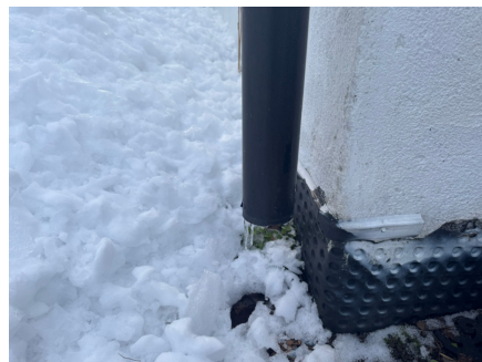
Nedløp som er avsluttet ved grunnmuren.
