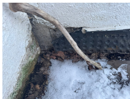
Utvendig fuktsikring er avsluttet ved tilbygget.
