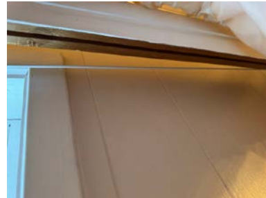
Ventil innvendig er kledd over med plater.
