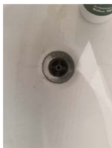
Eksempel på riss i utstyr på våtrommet.
