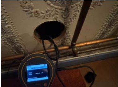
Fuktmåling mot dusjhjørne.
