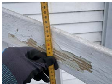
Høyde på rekkverk i trappen.
