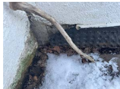
Utvendig fuktsikring er avsluttet ved tilbygget.
