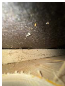
Innvendig i vegg hvor fuktmålingen er foretatt.
