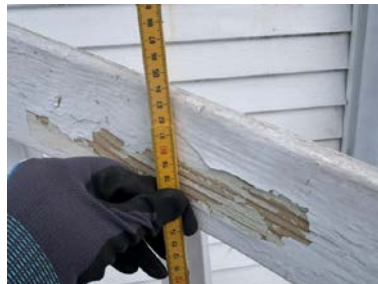
Høyde på rekkverk i trappen.
