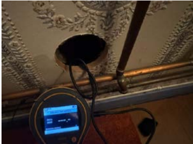
Fuktmåling mot dusjhjørne.
