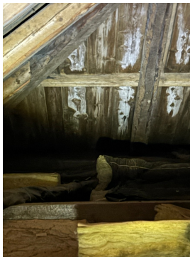
Viser loft med noe sopp på undertaket
