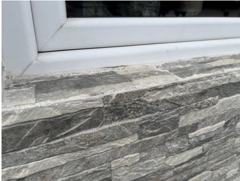
Viser flislegging inn mot vinduer.
