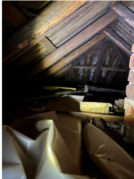
Viser loft med noe sopp på undertaket
