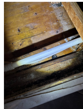
Viser uisolerte vannledninger på kott i 2 etg
