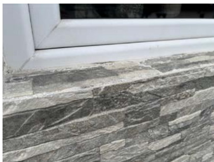
Viser flislegging inn mot vinduer.
