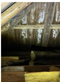
Viser loft med noe sopp på undertaket
