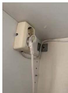
Viser for tynn kabel til kontakt.
