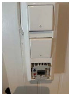
Viser for tynn kabel til kontakt.
