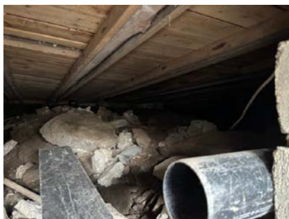
Viser deler av krypkjeller
