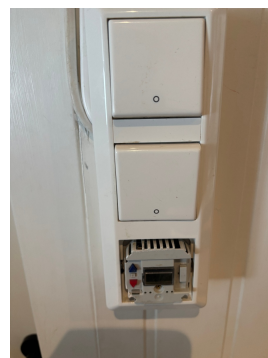
Viser for tynn kabel til kontakt.
