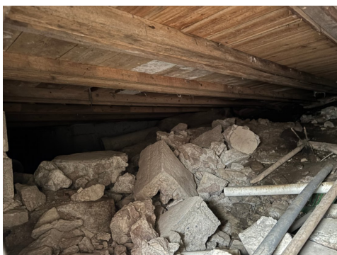
Viser deler av krypkjeller
