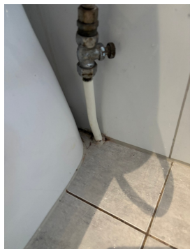
Viser rørgjennomføring i gulvet.
