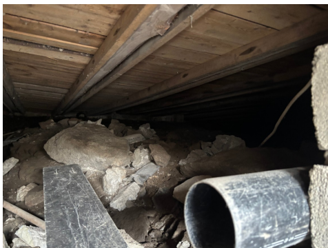
Viser deler av krypkjeller
