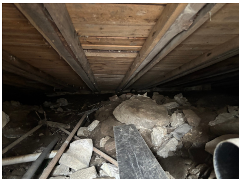
Viser deler av krypkjeller
