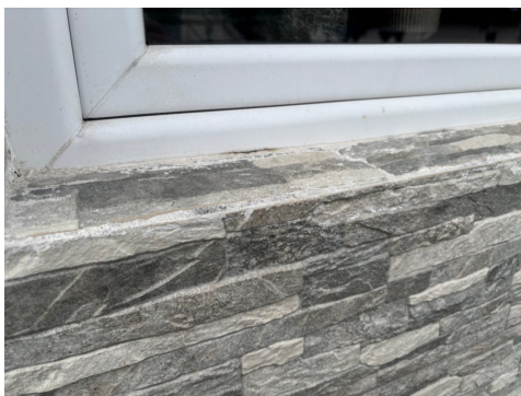
Viser flislegging inn mot vinduer.
