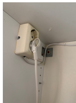
Viser for tynn kabel til kontakt.
