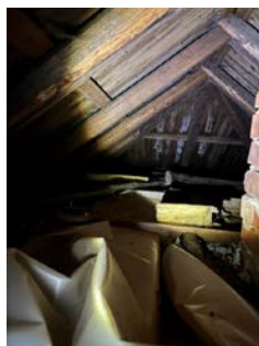
Viser loft med noe sopp på undertaket
