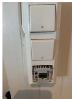
Viser for tynn kabel til kontakt.
