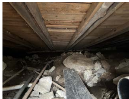
Viser deler av krypkjeller
