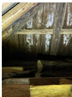
Viser loft med noe sopp på undertaket
