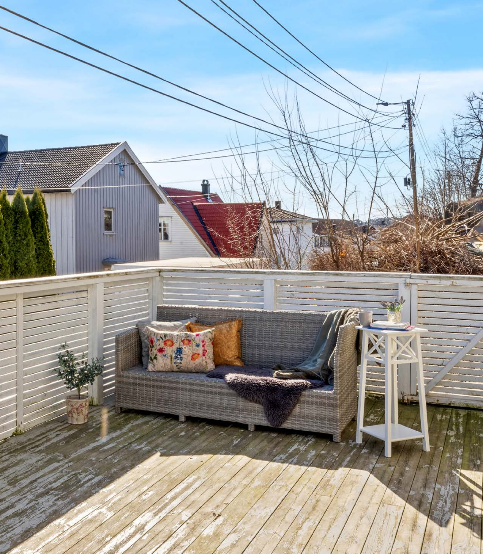
Terrasse utenfor under/sokkeletg
