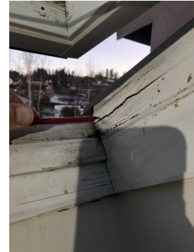
Bilde av råteskade på takvindu
