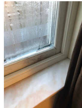
Bilde av råteskade på takvindu
