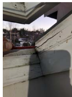
Bilde av råteskade på takvindu
