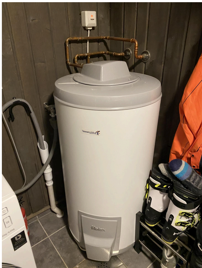
Varmtvannstank fra byggeåret.
