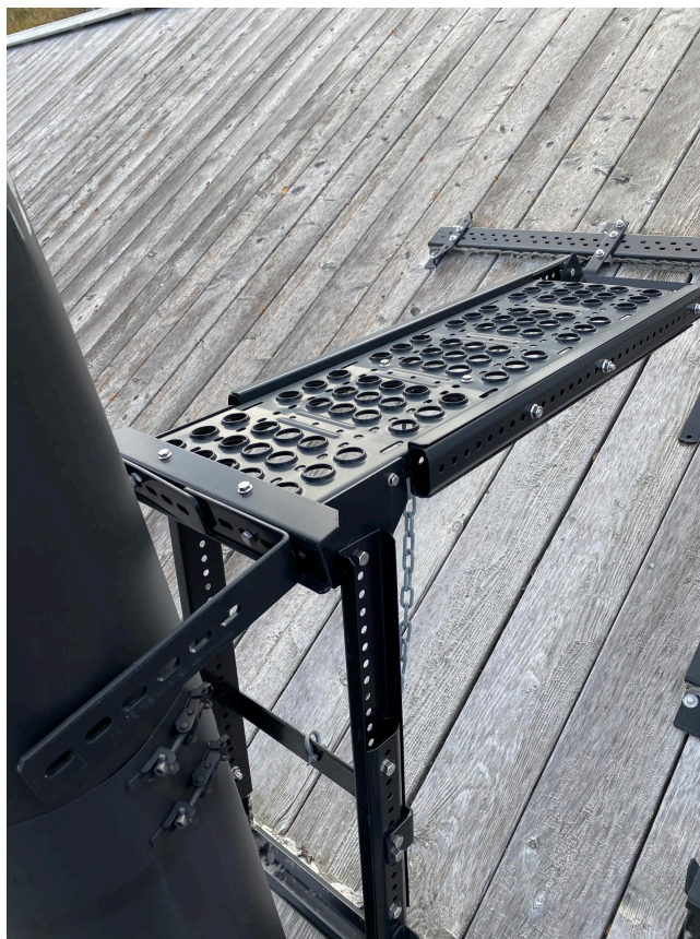
Forskriftsmessig takstige og plattform.
