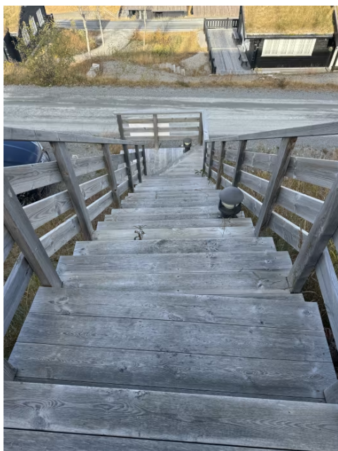
Trapp i terreng til innkjørsel.
