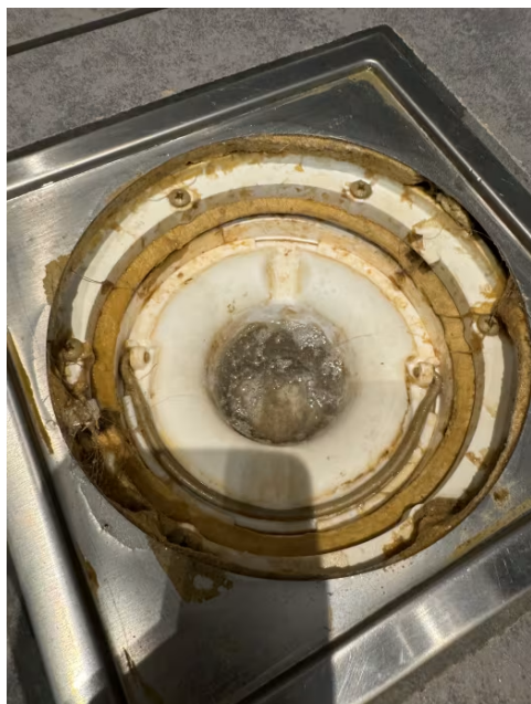
Sluk med membran under klemring.
