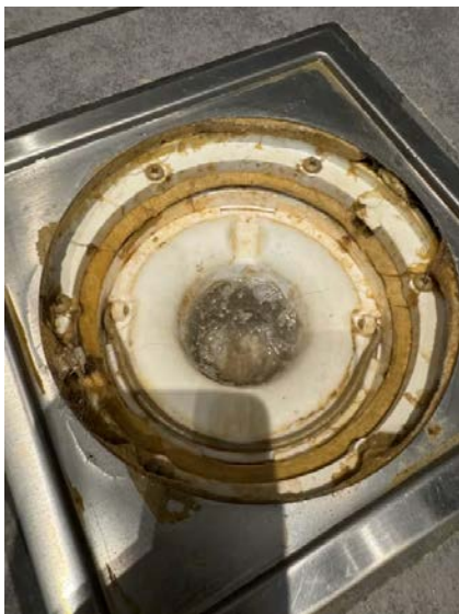
Sluk med membran under klemring.
