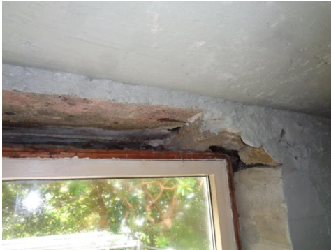
Åpent rundt vindu i stue i kjeller.
