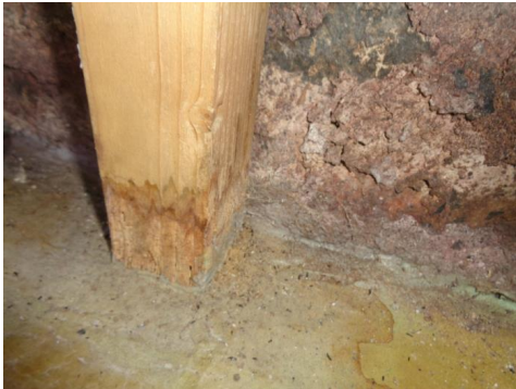
Vanger står på treklosser mot grunn. Fuktoppsug fra dekke.
