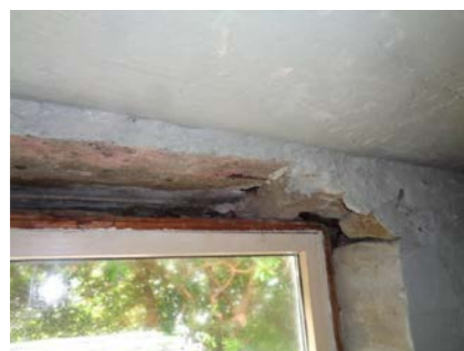
Åpent rundt vindu i stue i kjeller.
