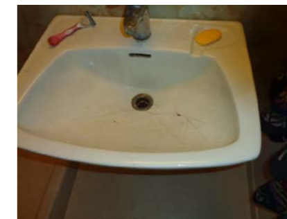
Sprekk i servant.
