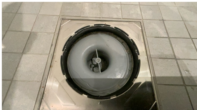
Kontroll av sluk.
