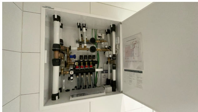
Besiktigelse av røropplegg.
