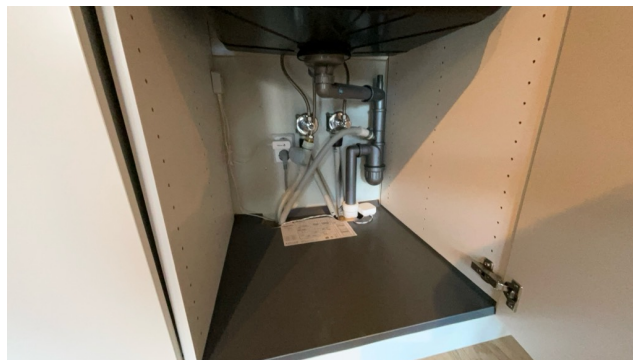
Besiktigelse av røropplegg.
