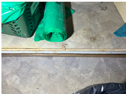
Fuktsvelling/bruksmerker i benkeskap.
