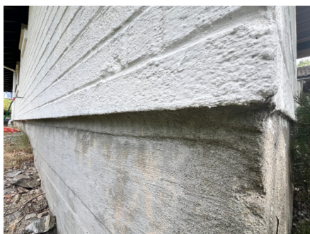
Ingen drenering i bunn på skallmur konstruksjon
