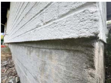
Ingen drenering i bunn på skallmur konstruksjon
