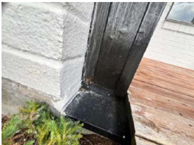
Ingen drenering i bunn på skallmur konstruksjon
