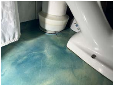
Lav oppbrett rundt rør.
