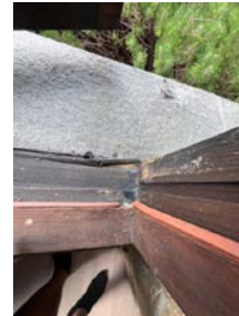
Skade på karm og kort pakning
