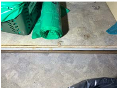
Fuktsvelling/bruksmerker i benkeskap.
