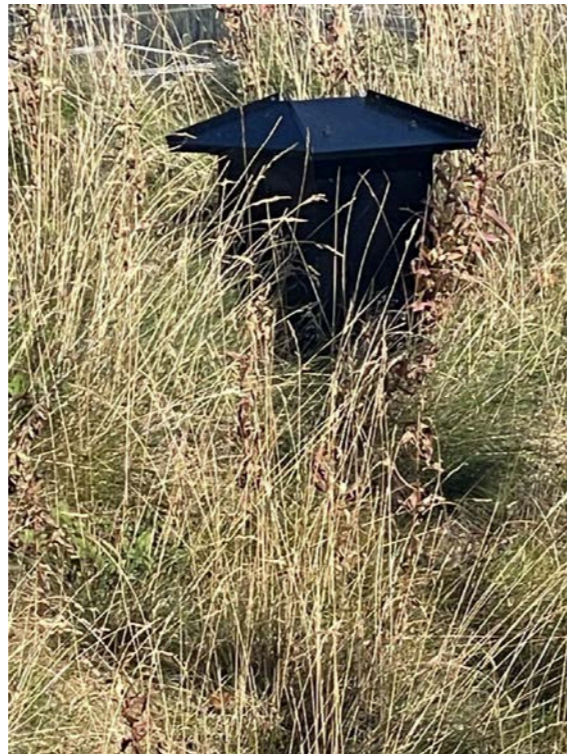
Utvendig lufter hatt for kloakk, er beslått med blikk.
