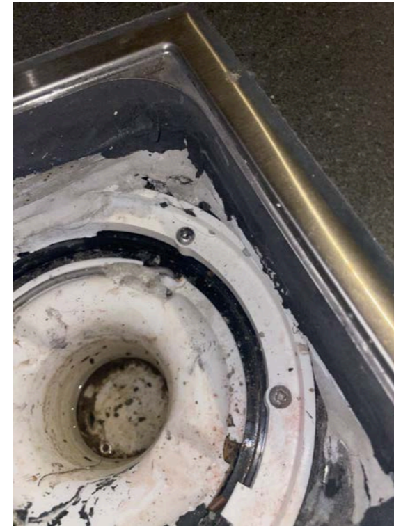
Sluk i gulv på teknisk rom.
