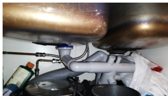
Kontroll av røropplegget.
