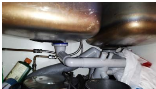
Kontroll av røropplegget.
