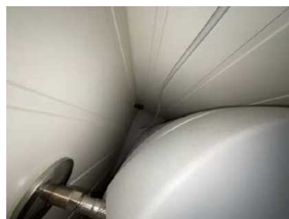
Eventuelt lekkasjevann ledes mot sluk.
